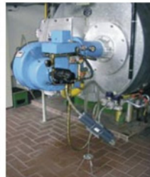
Der Ecojet wurde vor die Brenner auf die Zuleitung montiert
